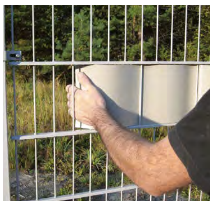
Taśma ogrodzeniowa montowana na panelach ogrodzeniowych.
