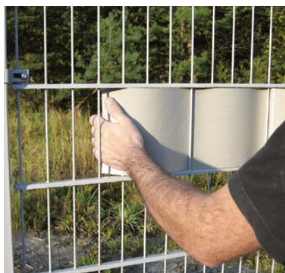
Taśma ogrodzeniowa montowana na panelach ogrodzeniowych.
